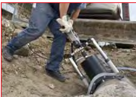
Anbohren von Betonrohr – nass, stativgeführt
