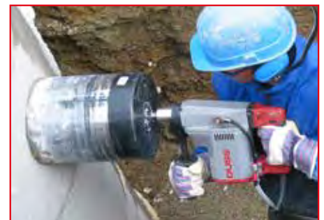
Anbohren von Betonschacht – nass, handgeführt
