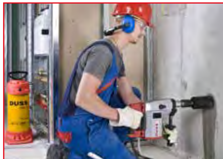
Dosensenken in Beton – nass, handgeführt
