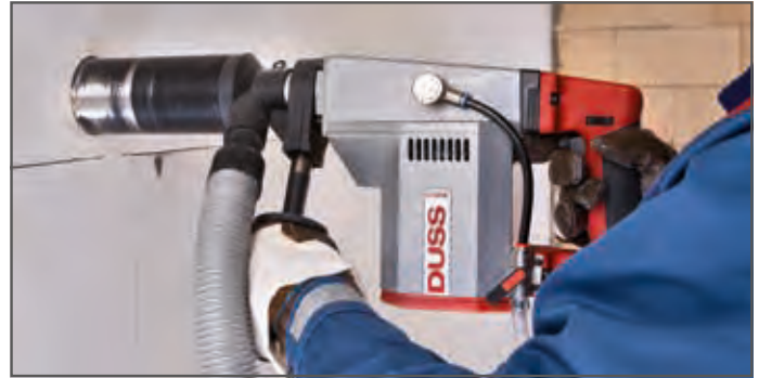
Dosensenken trocken in Kalksandstein mit Staubabsaugung
