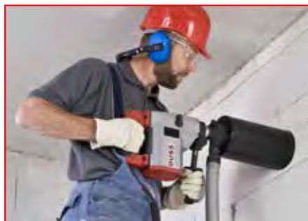
Trockenbohren in Mauerwerk mit Staubabsaugung, handgeführt
