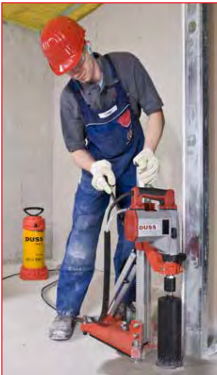
Nassbohren in Beton, ständergeführt
