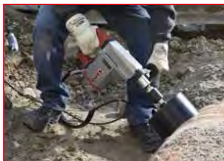
Anbohren von Kunststoffrohr – trocken, handgeführt
